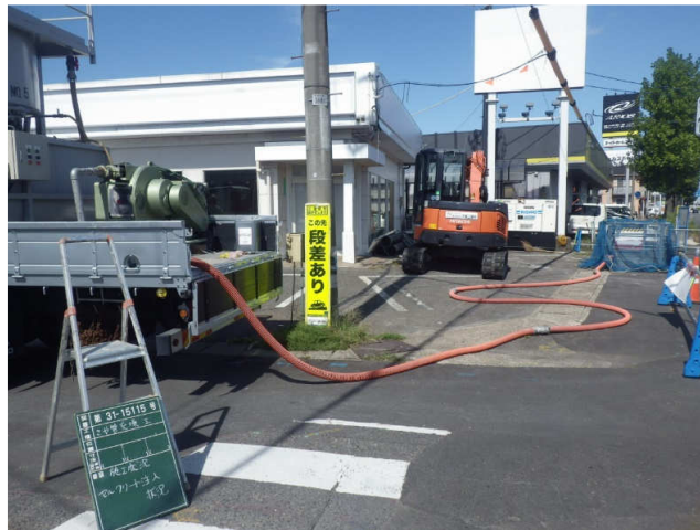
注入口①(推進鞘管空隙充填)
