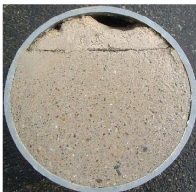
エアモルタル
