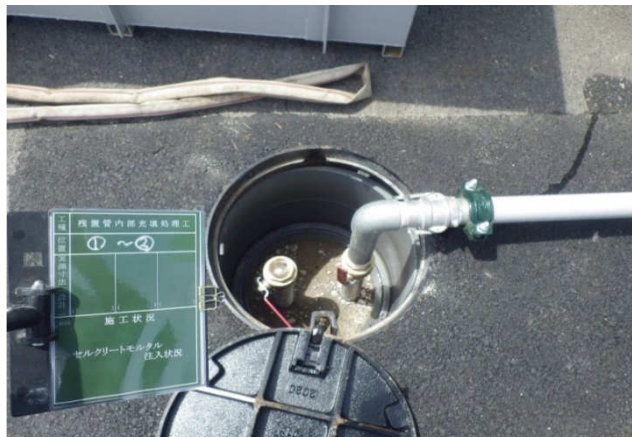
注入口 \phi 50\text{mm} \times 2 (両側注入口)
