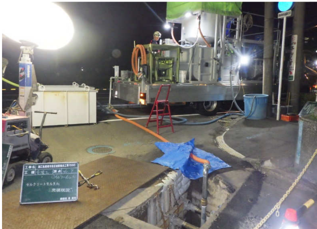
車上式プラントヤード
