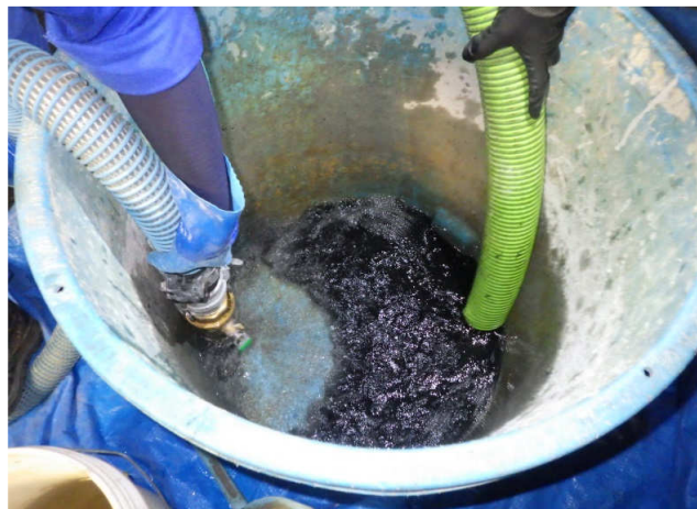
吐出口 残留污水回収状況 φ 50mm
