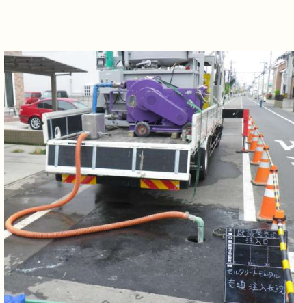
プラント車配置状況
