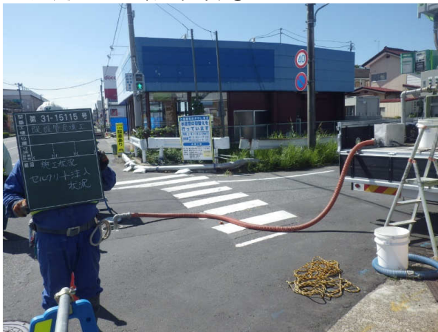
注入口②(既設管) \phi 50\text{mm}
