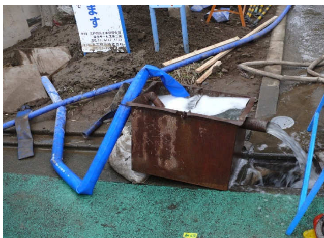
吐出口 管内充填に伴う残留水排水
