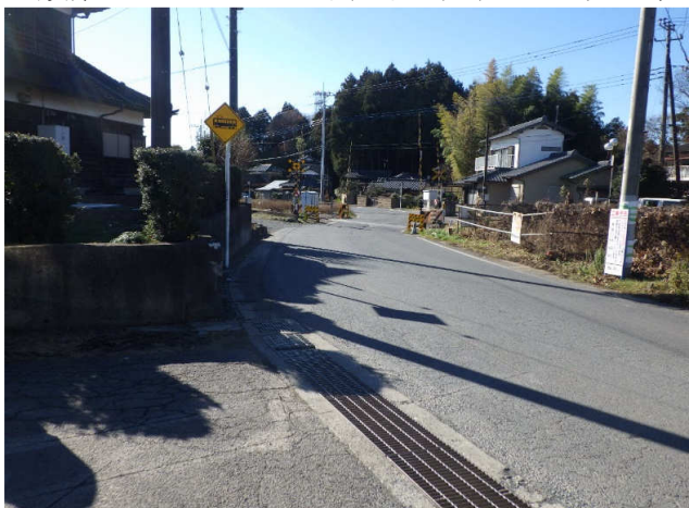
注入口側(昼間通常時)
