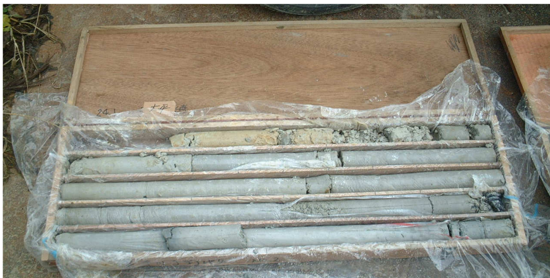
事後、ボーリング調査にて材料分離や空隙が無いことを確認
