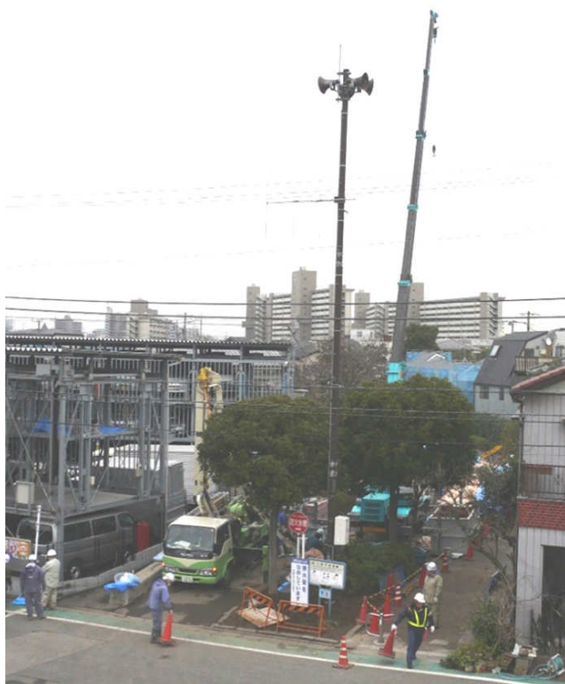
定置式プラント施工状況
