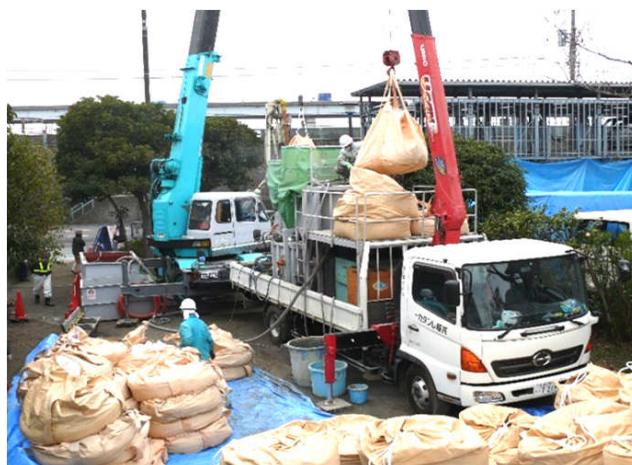
車上式プラント施工状況
