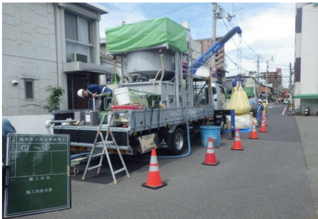
車上式プラント 作業ヤード
