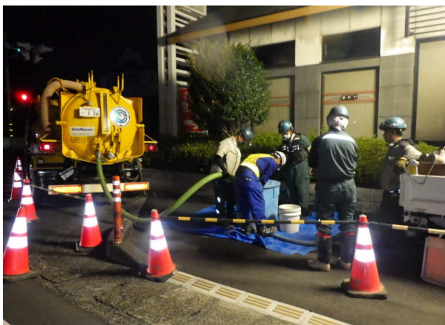
吐出口作業ヤード
