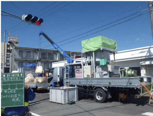
車上式プラントヤード
