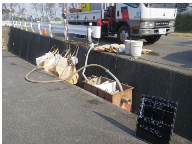
吐出口 管内充填に伴う残留水排水
