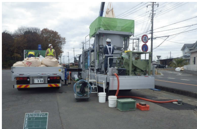
車上式プラントヤード
