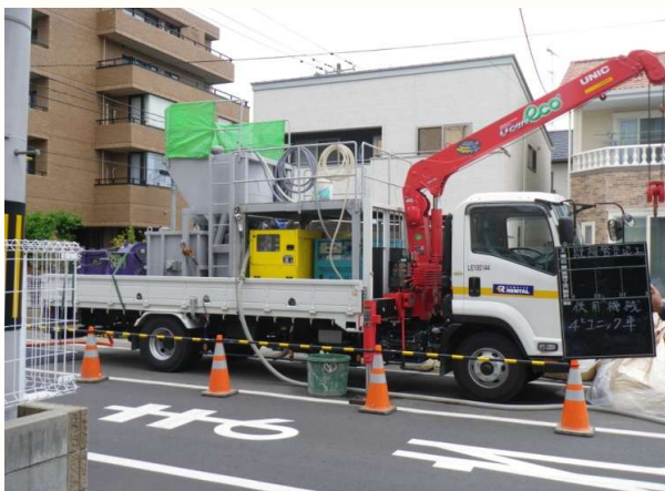
車上プラント攪拌・注入設備
