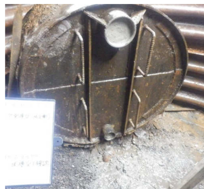
吐出口 配管撤去
