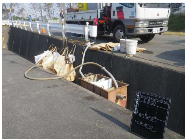
吐出口 管内充填に伴う残留水排水
