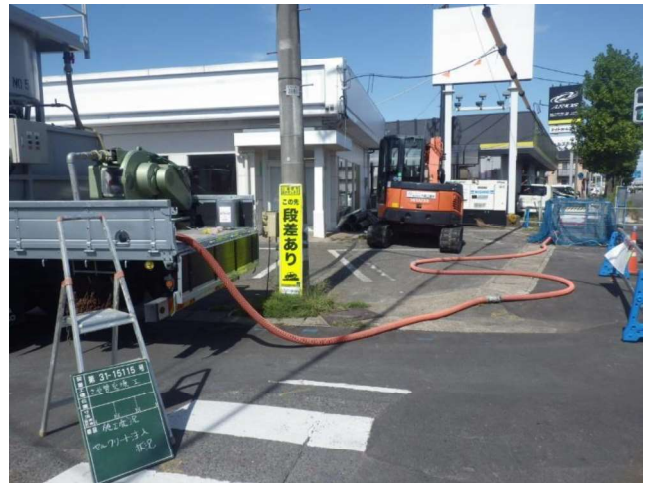
注入口①(推進鞘管空隙充填)
