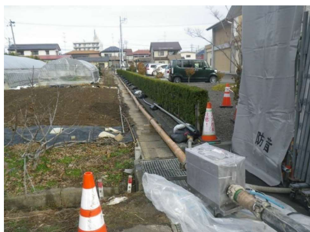
コンクリートポンプ車圧送管 約100m配管
