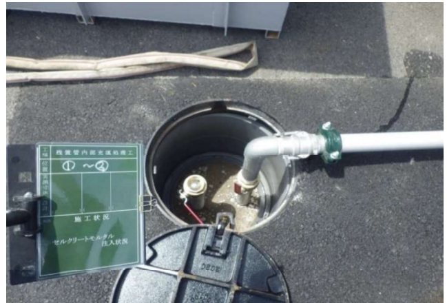
注入口 \phi 50\text{mm} \times 2 (両側注入口)
