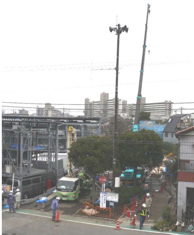
定置式プラント施工状況
