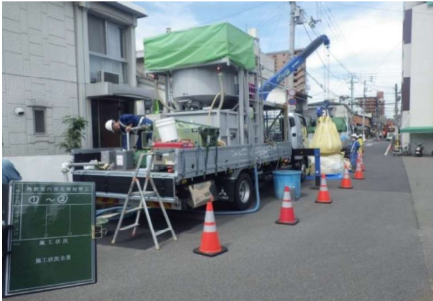
車上式プラント 作業ヤード
