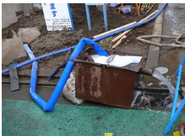
吐出口 管内充填に伴う残留水排水
