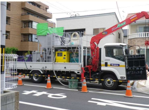
車上プラント攪拌・注入設備
