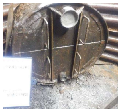
吐出口 配管撤去
