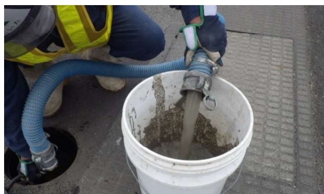
分水管② 吐出確認
