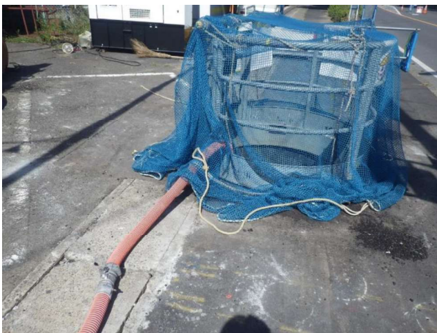
注入口①(推進立坑) φ 50mm
