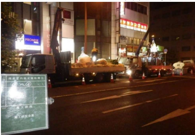
交差点付近 2車線道路 左折車線規制
