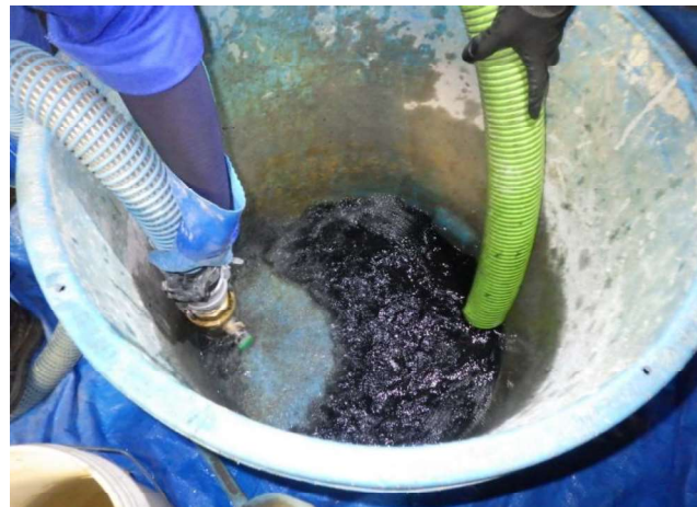
吐出口 残留污水回収状況 φ 50mm
