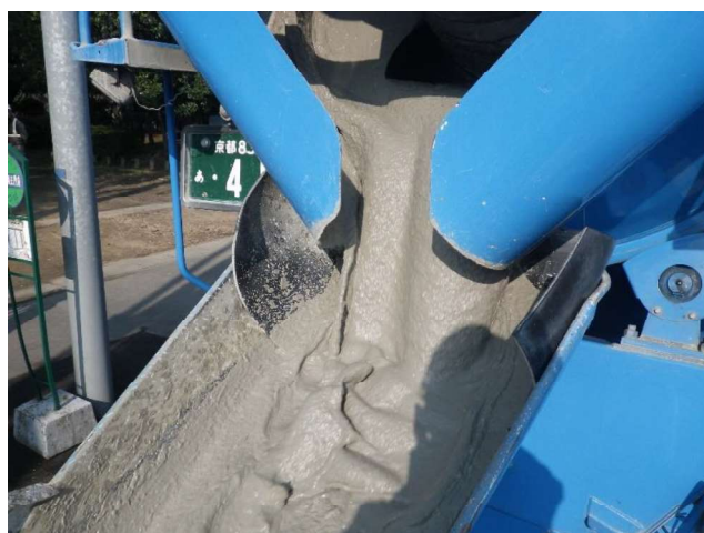
コンクリートポンプ車へ投入
