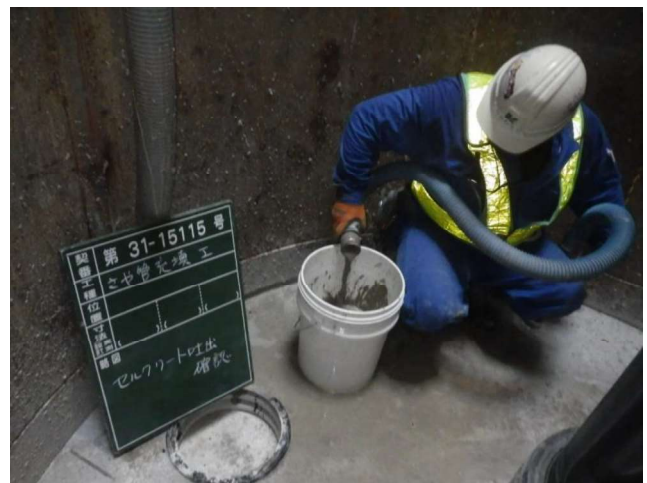
吐出口①(推進鞘管空隙充填) φ 50mm
