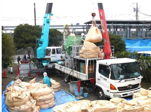
車上式プラント施工状況
