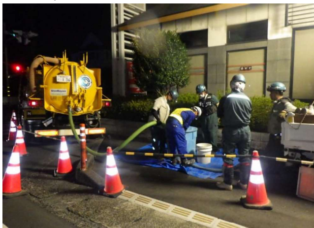
吐出口作業ヤード
