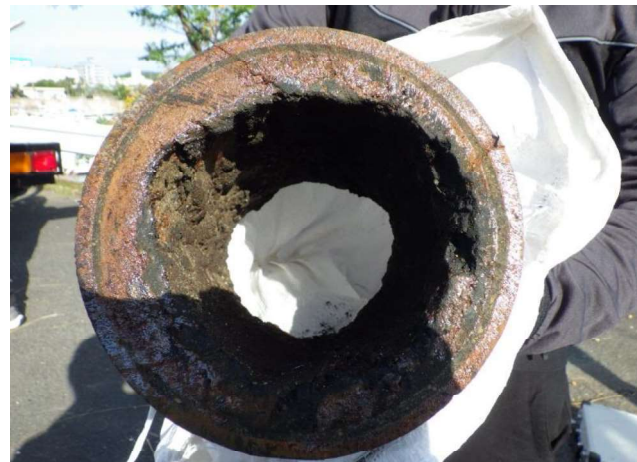
充填管切断面
