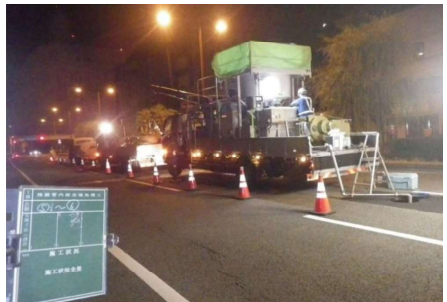
3車線道路 中央車線規制
