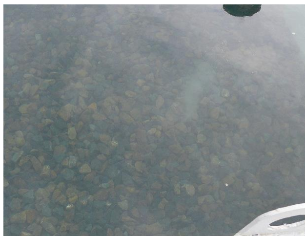
注入最終段階：充填の進行に伴う漏出状況 気泡の浮上に追従か
