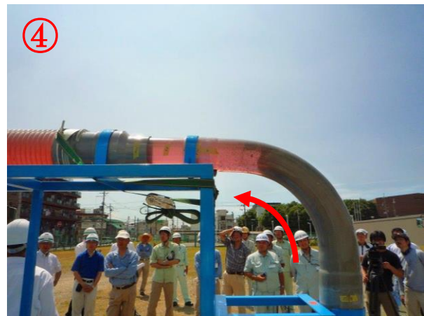
屈曲部の充填確認（吐出側）
