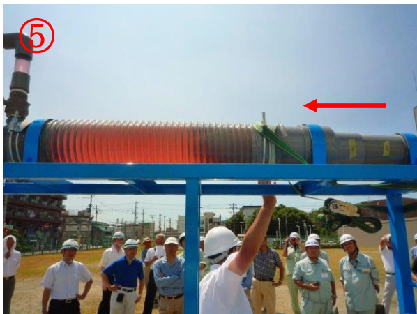
伏越し後充填先端部
