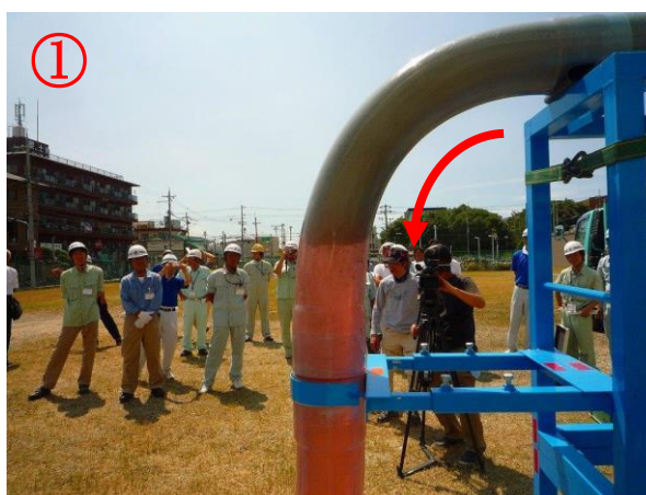
屈曲部の充填確認（下方向）
