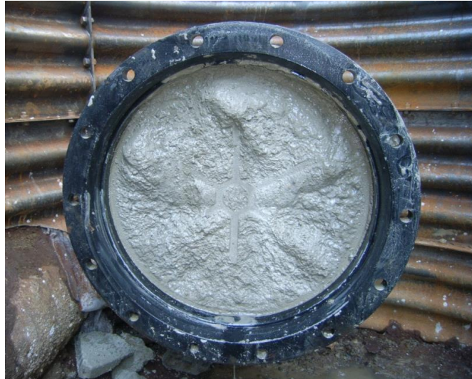
到達側端部閉塞型枠取外し後の状況（φ450mm）
