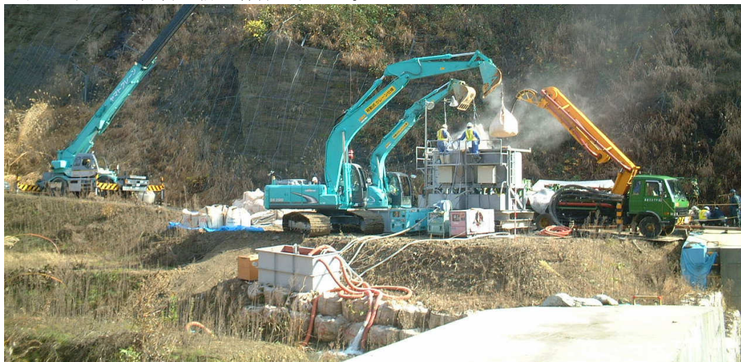
定置式プラントヤード 2連2組 (充填材料 常時小運搬納入)
