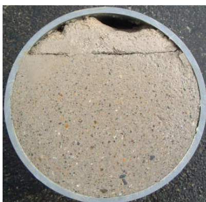
エアモルタル
