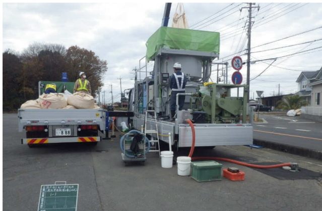
車上式プラントヤード
