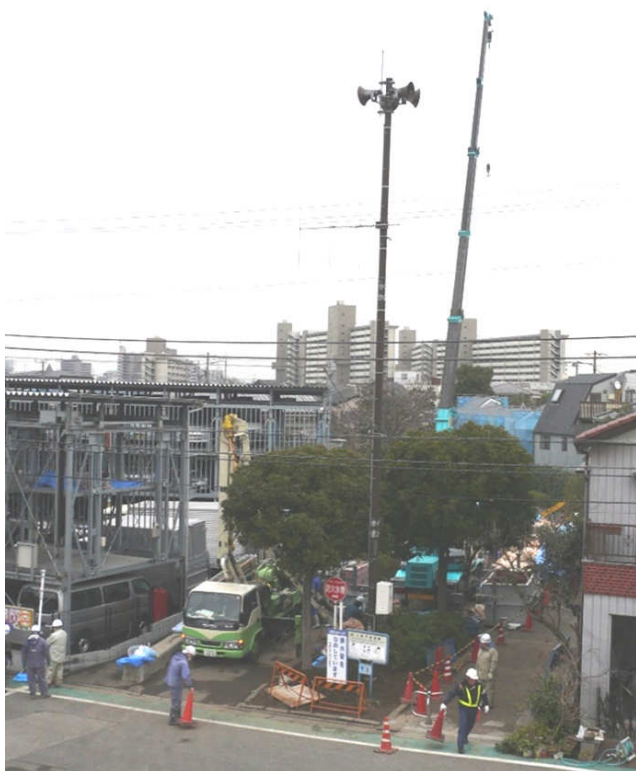
定置式プラント施工状況
