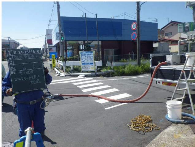
注入口②(既設管) \phi 50\text{mm}
