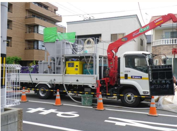
車上プラント攪拌・注入設備
