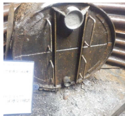
吐出口 配管撤去
