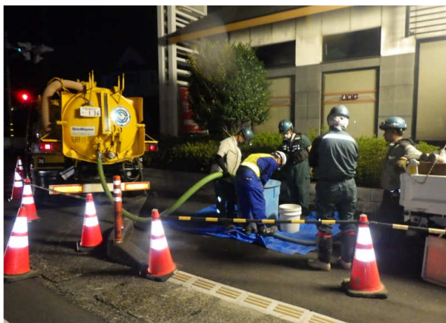
吐出口作業ヤード
