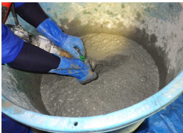
吐出口 吐出確認
