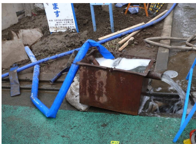
吐出口 管内充填に伴う残留水排水
