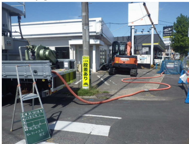
注入口①(推進鞘管空隙充填)
