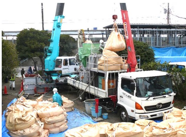
車上式プラント施工状況
