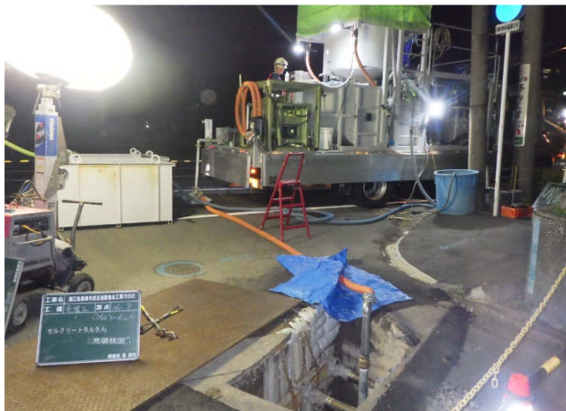
車上式プラントヤード
