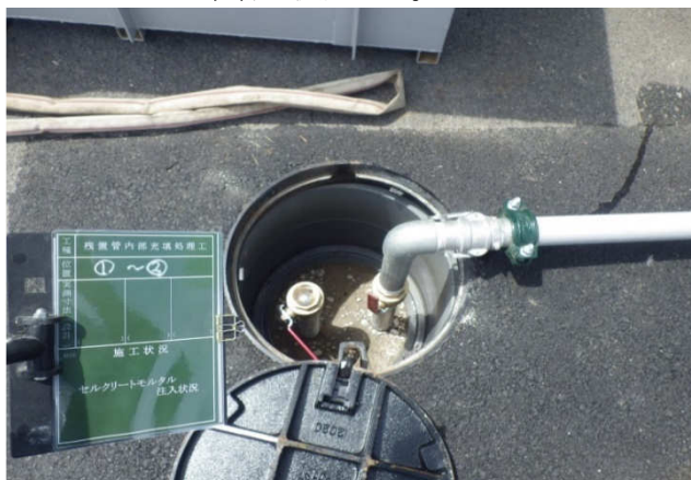
注入口 \phi 50\text{mm} \times 2 (両側注入口)
