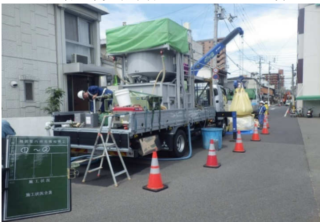
車上式プラント 作業ヤード
