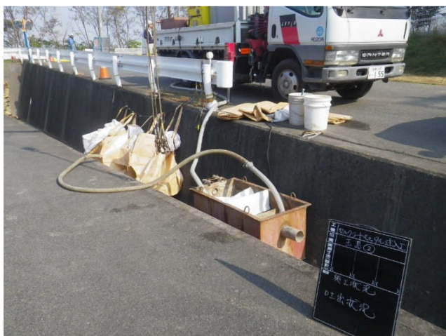
吐出口 管内充填に伴う残留水排水
