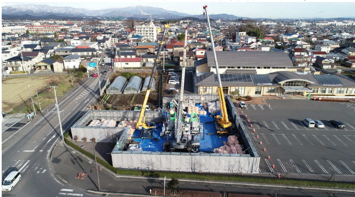
定置式プラントヤード(2連3組 充填材料 1区間分約500m 3 分納入)
