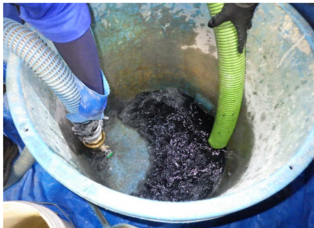
吐出口 残留汚水回収状況 φ50mm
