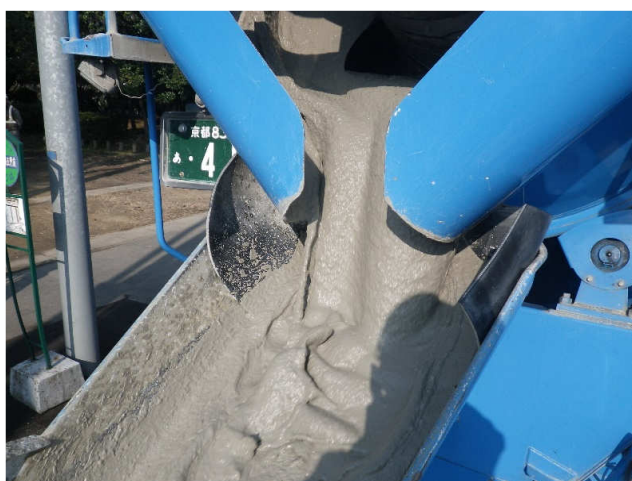
コンクリートポンプ車へ投入
