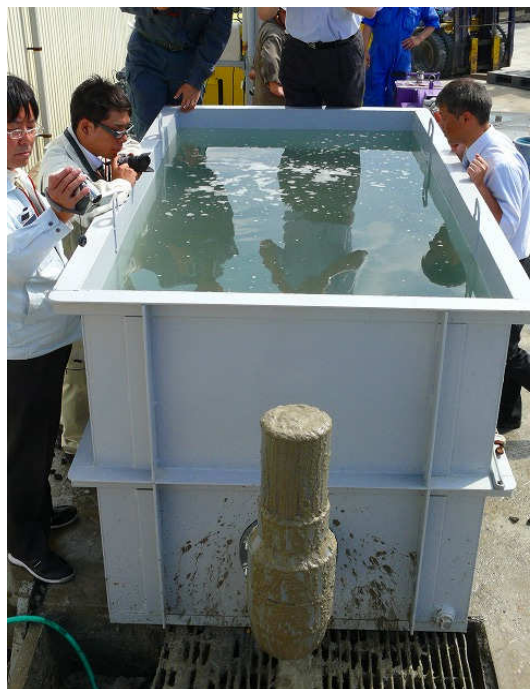
管内充填完了時の状況 吐出管からの充填材流出を確認水槽内は清水状態を保つ
