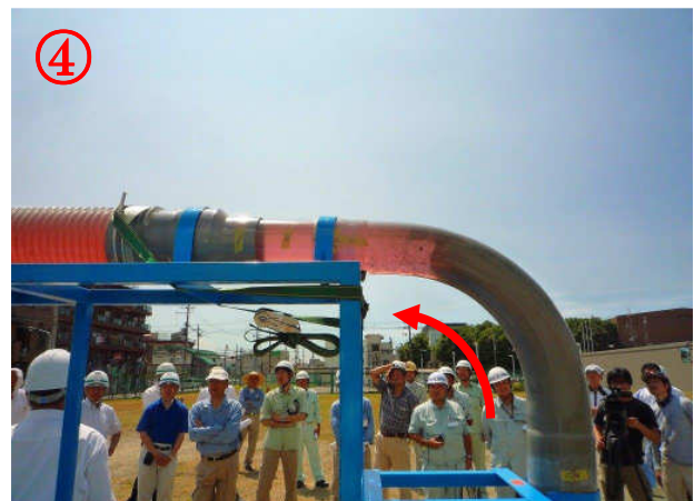
④ 屈曲部の充填確認（吐出側）
