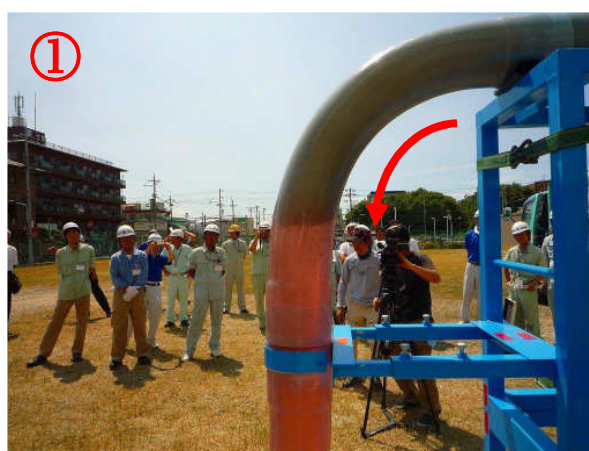
① 屈曲部の充填確認（下方向）
