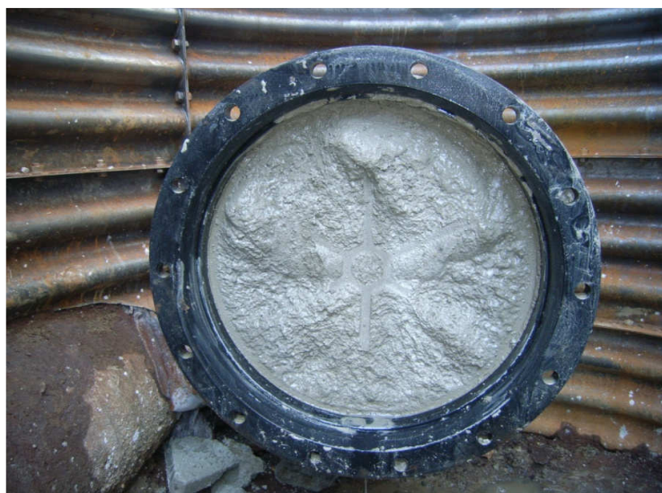
到達側端部閉塞型枠取外し後の状況（φ450mm）
