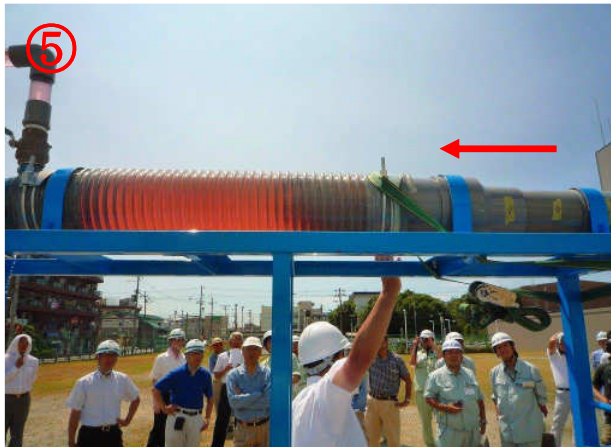
⑤ 伏越し後充填先端部
