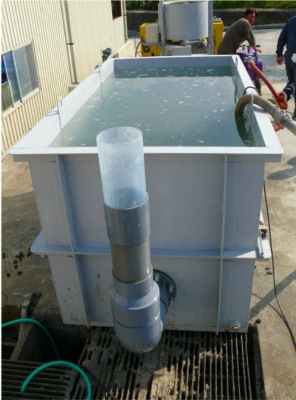
水槽湛水面までの充填後、吐出口嵩上げ管を取り付けた状態
