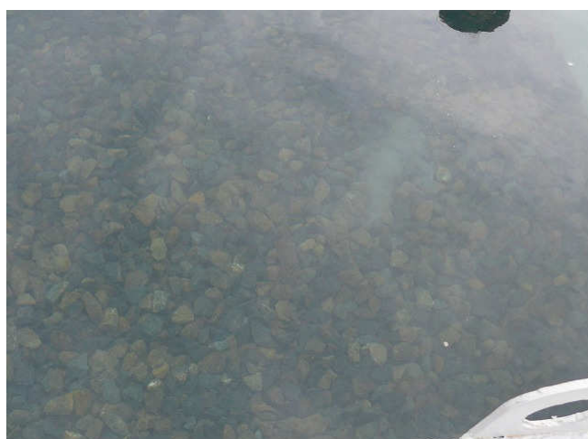
注入最終段階：充填の進行に伴う漏出状況 気泡の浮上に追従か
