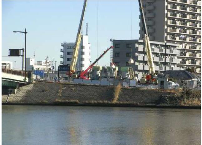
充填完了後の廃止管撤去の様子
