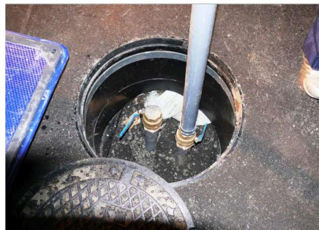
到達側管内滞留水処理設備
