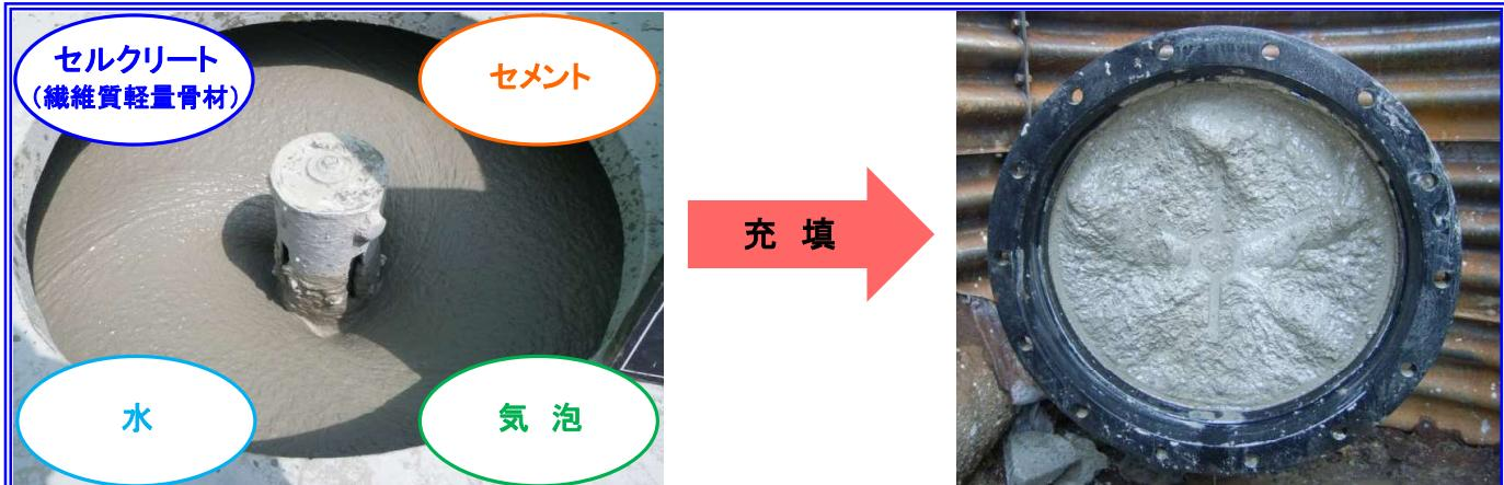
『セルクリート工法』の注入材料は、繊維質混和材と独立気泡との相乗効果による
