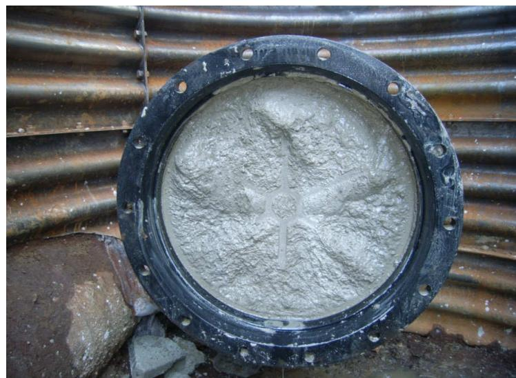
到達側端部閉塞型枠取外し後の状況（ $\phi 450\text{mm}$ ）
