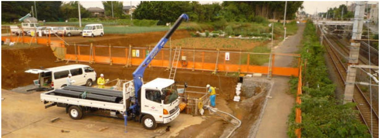
注入充填用車載式プラント設備設置状況(発進基地側)
