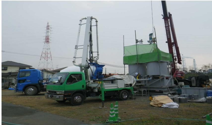
コンクリートポンプ車による注入設備
