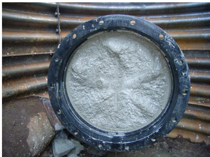
到達側端部閉塞型枠取外し後の状況（ \phi 450mm）
