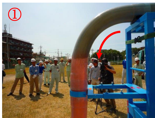
屈曲部の充填確認（下方向）
