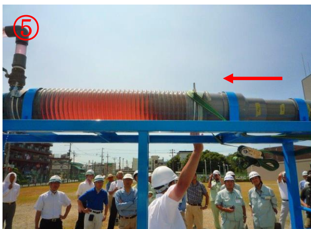
⑤ 伏越し後充填先端部
