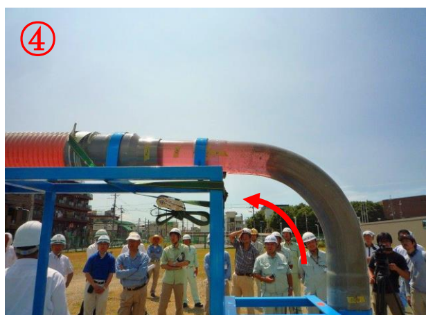
④ 屈曲部の充填確認（吐出側）
