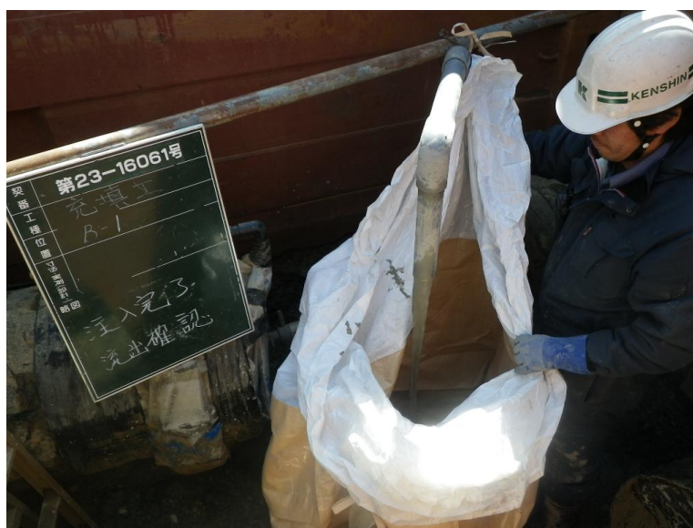
到達口にてセルクリートの吐出を確認
