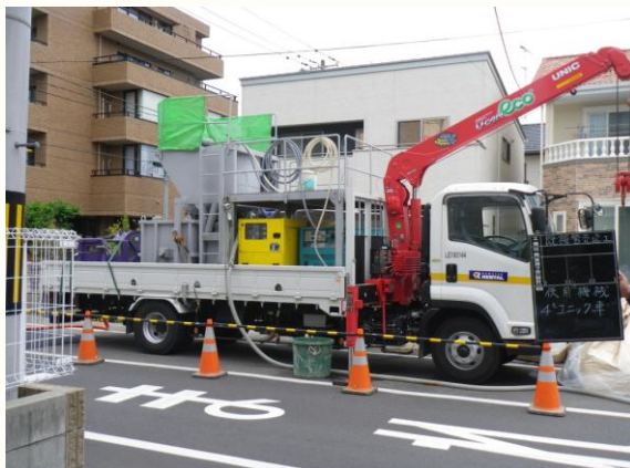
車上プラント攪拌・注入設備
