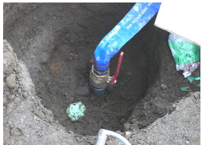
充填完了の確認 吐出口からの流出状況
