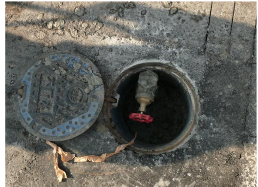
注入口(充填完了時)の状況
