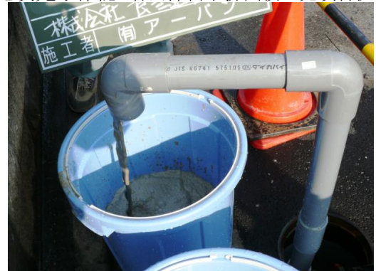
充填完了確認:管内滞留水排出後の充填材流出
