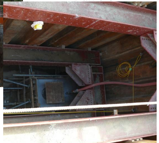
注入口設備設置状況
