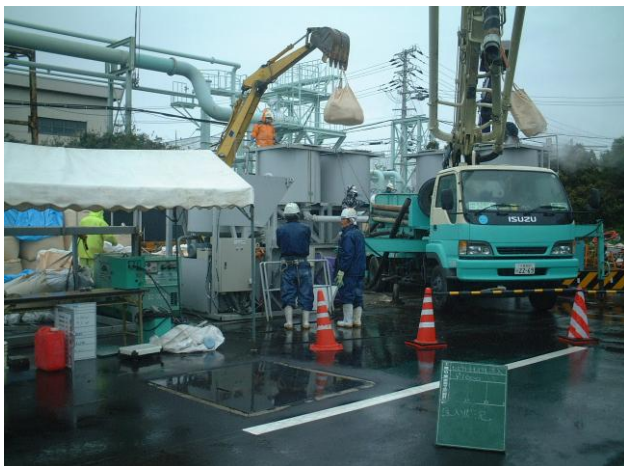
コンクリートポンプ車による注入設備
