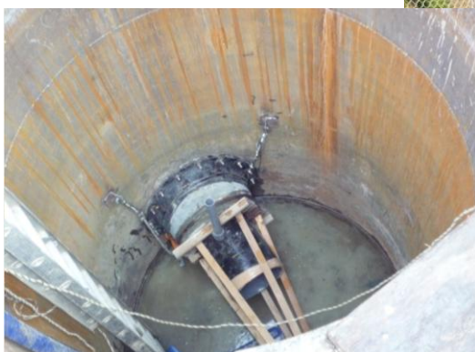
到達側吐出管設備設置状況
