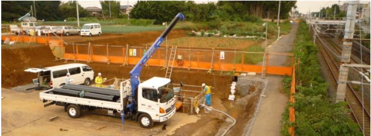
推進管発進立坑設備
