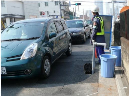
到達側 吐出口設備の状況
