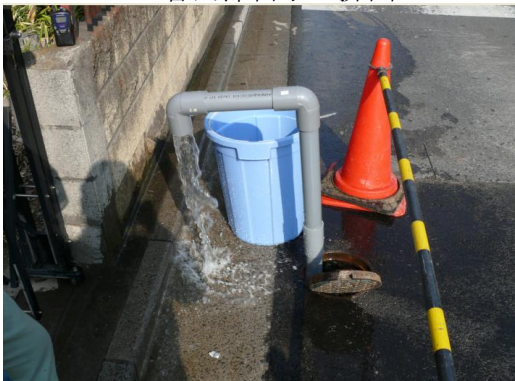
管内滞留水の排出
