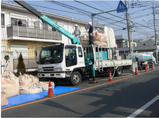
注入側作業状況
